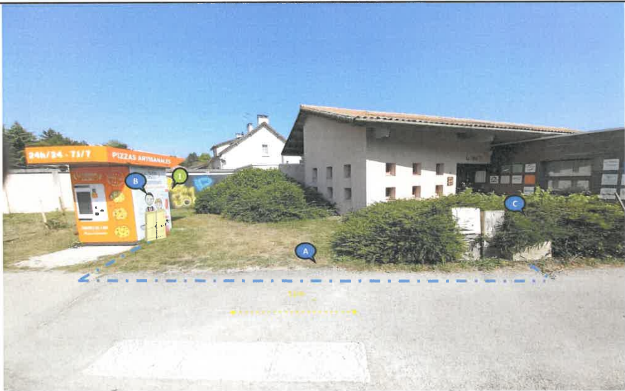
La solution technique est déterminée dans le respect de la norme NFC 14-100 en vigueur. Photo compteur non contractuelle
